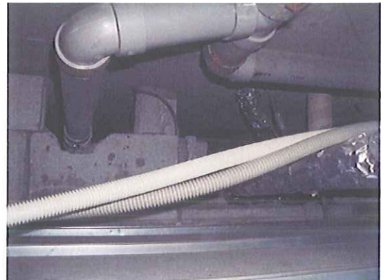
④ 東庁舎1階トイレ コンクリートブロック造壁上部の定着固定状況 コンクリートブロック壁の改修が望ましい
