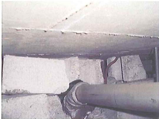
④ 東庁舎1階トイレ コンクリートブロック造壁上部の定着固定状況 コンクリートブロック壁の改修が望ましい
