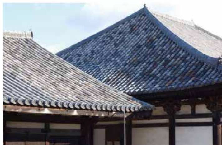
写真1：本瓦葺きの屋根瓦（奈良県元興寺）
