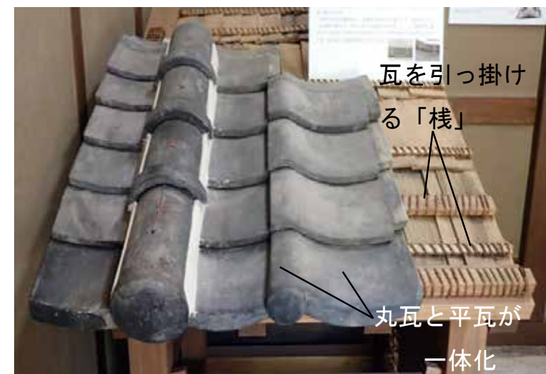
写真4：棧瓦葺きの葺き方（高山社跡長屋門）
