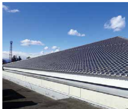
写真2：棧瓦葺きの屋根瓦（藤岡歴史館）
