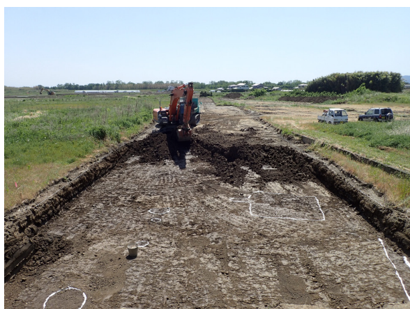
重機での掘削の様子
