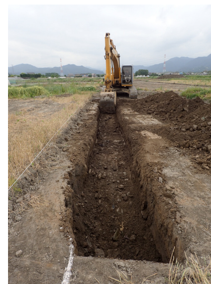
重機での掘削写真 (遺跡が見つかる面まで平らに下げていきます)
