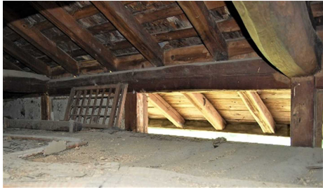
2階簀の子天井上部(背面)
