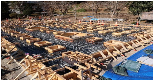
基礎コンクリート・型枠・鉄筋配置
