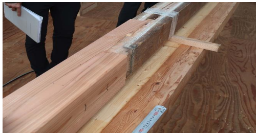
柱材普及部分の新補材木継(木工事)
