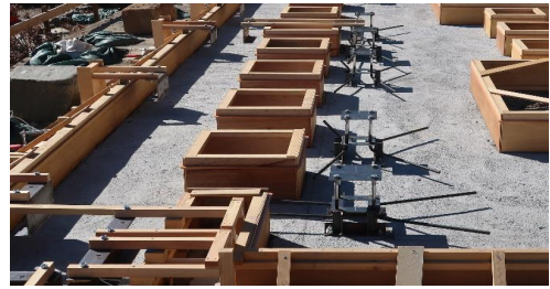
耐震補強金具 設置
