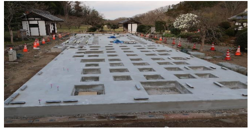
基礎工事・ベタ基礎コンクリート打設 完了
