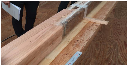
柱材普及部分の新補材木継(木工事)
