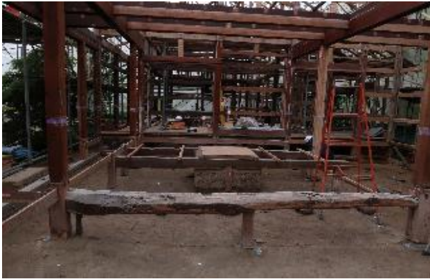
解体中の母屋兼蚕室
