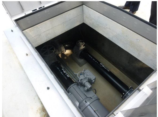
マイクロ水力発電設置予定地（南山配水池）
