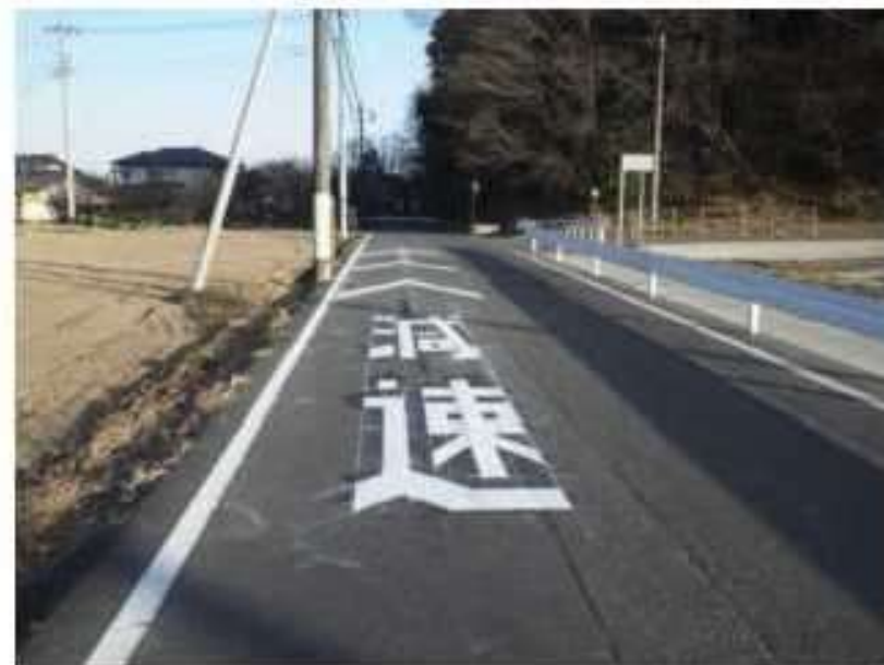
【対策施行後】 見通しが悪いカーブ手前に「減速」の路面標示を追加した。
