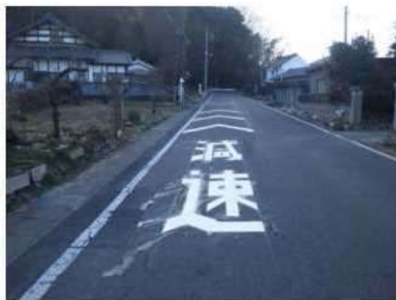
【対策施行後】 見通しが悪いカーブ手前に「減速」の路面標示を追加した。
