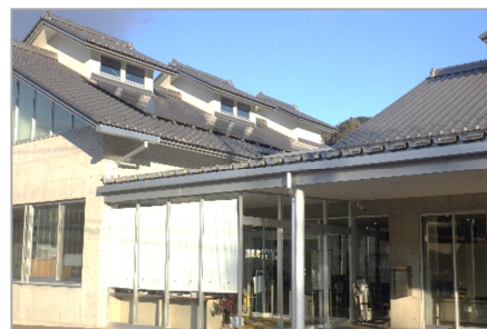
太陽光発電（鬼石総合支所）
