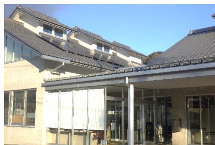
太陽光発電(鬼石総合支所)
