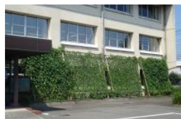
庁舎内に設置したグリーンカーテン
