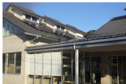
太陽光発電(鬼石総合支所)
