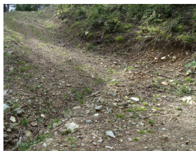
素掘りによる横断溝
