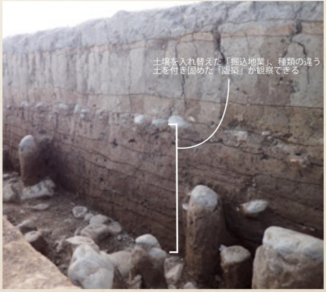
土壌を入れ替えた「掘込地業」、種類の違う土を突き固めた「版築」が観察できる
