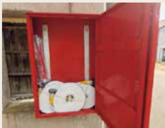
第74区に整備した消火栓用消防ホース・ホース格納箱B型 脚付
